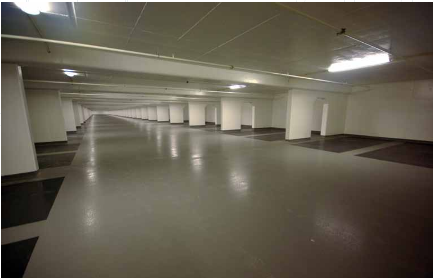
Deckshield ferdig utført
